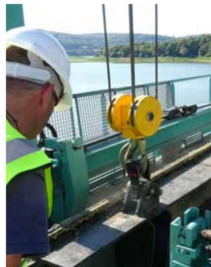
Manœuvres sur le barrage de Pannecièrre
