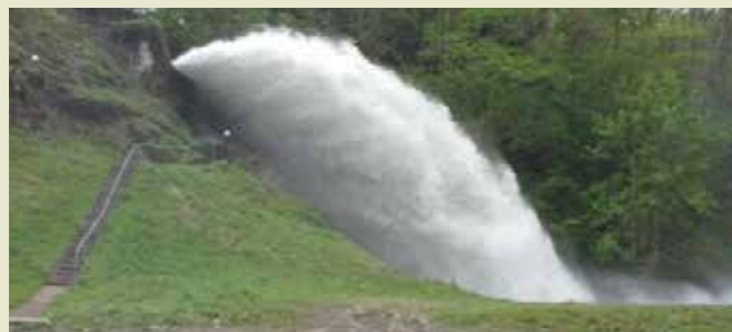
Évacuateur de crue Pannecière mai 2015
