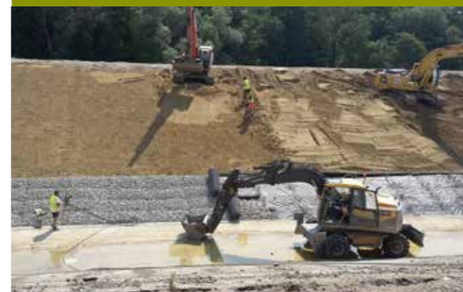
Travaux sur le canal d'aménée Seine
