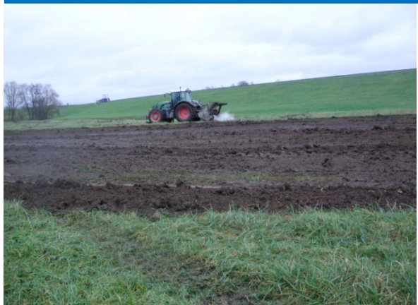
Arasement des souches :
