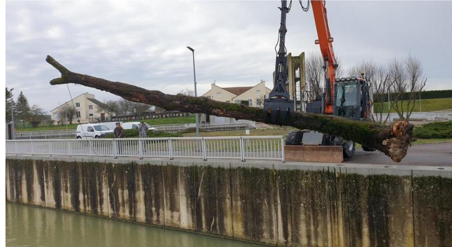
*Embâcles retirés des vannes du barrage en rivière Aube pendant l'événement – 04/02/2021*
