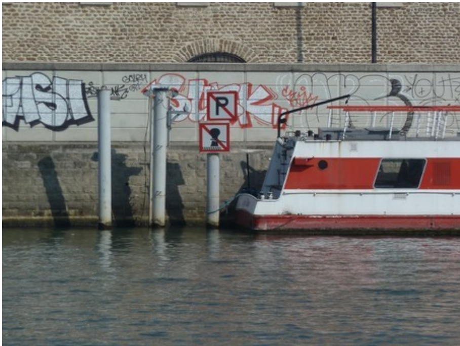
Pieux et sonde rive droite (23/03/11)
